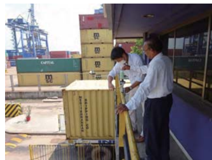
DPWターミナル のインゲート上屋 へのカメラ設置
