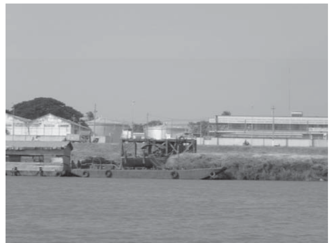
図-4 プノンペン港上流の石油基地
