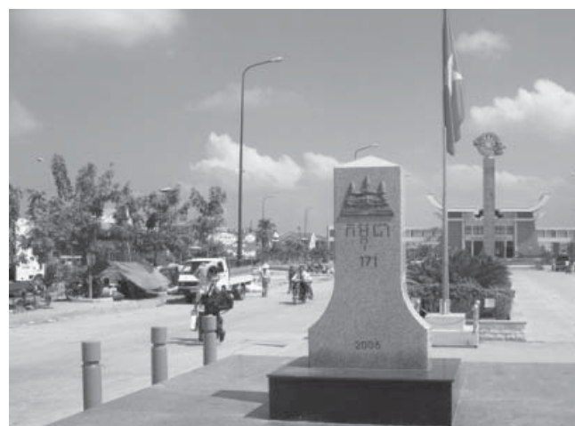
図-7 バベット国境施設 （内部中間点からベトナム側ゲートを望む）
