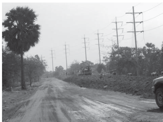
図-9 国道5号線の改良工事
