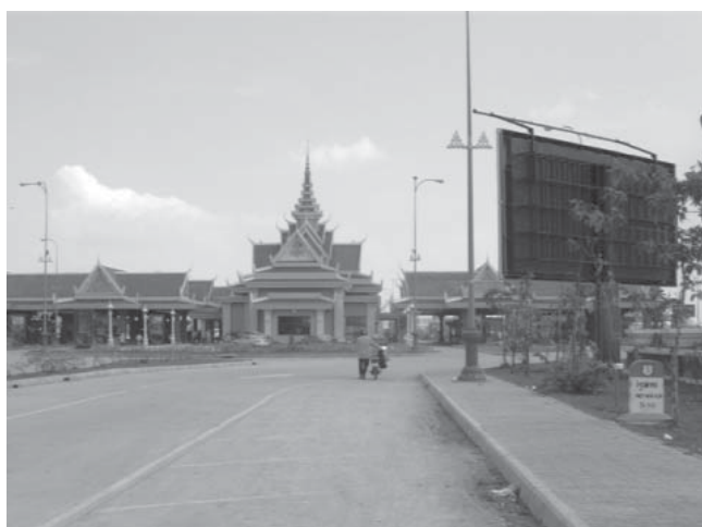
図-6 バベット国境施設（カンボジア側ゲート）
