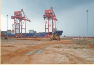
シハヌークビル港コンテナターミナル
