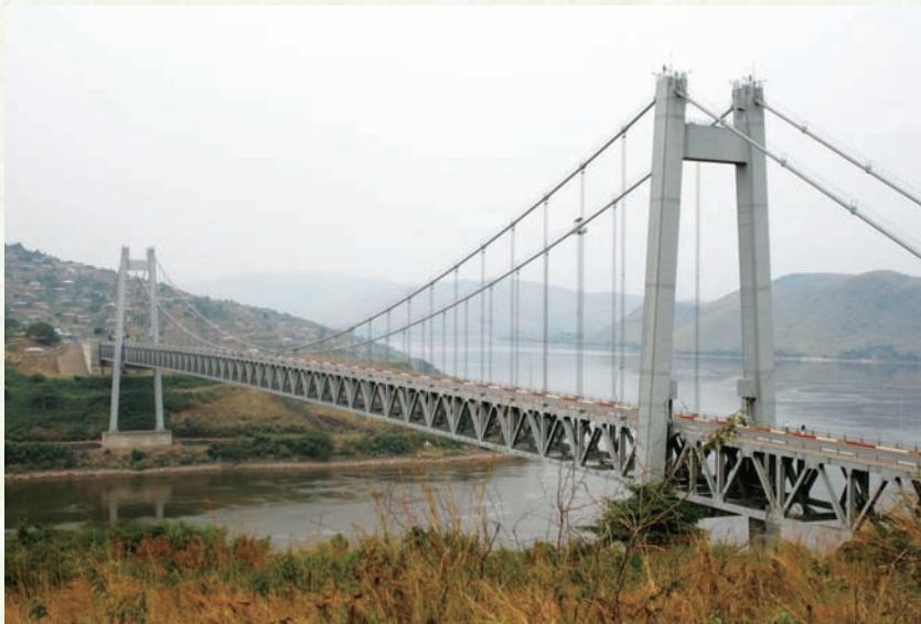
コンゴ民主共和国 マタディ橋（1983年竣工）
