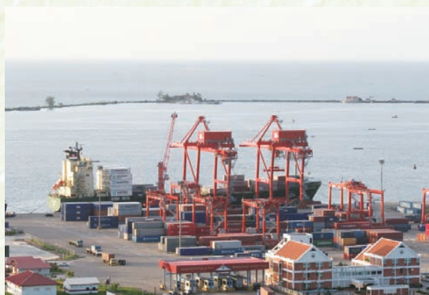
カンボジア国シアヌークビル港のコンテナターミナル
