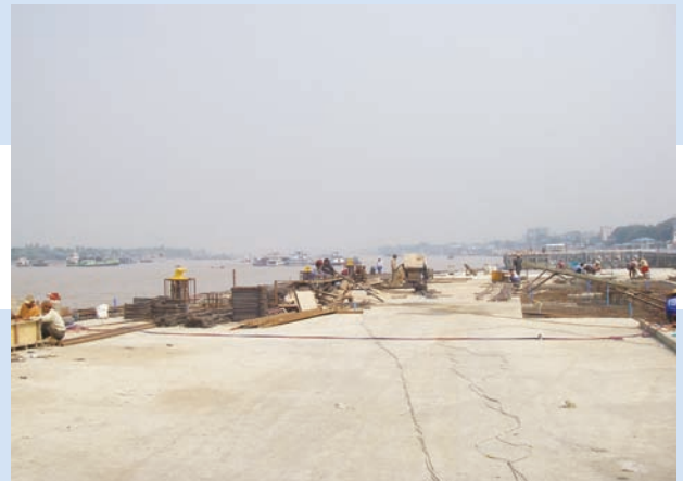
現在実施中の港湾拡張工事 -ヤンゴン港-
