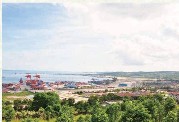
カンボジア国シアヌークビル港の全貌 写真提供：日本工営株式会社提供
