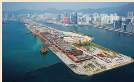
写真1 施工状況写真
