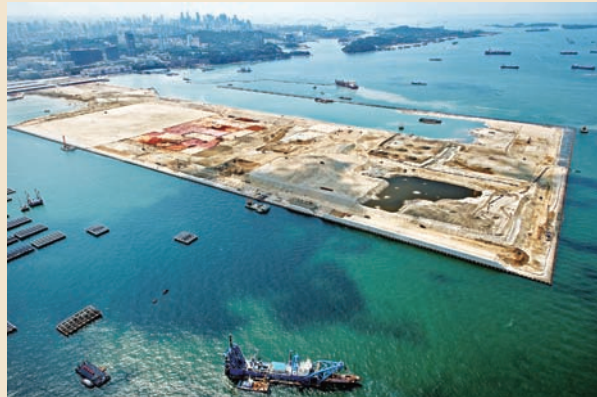
写真3 施工状況写真
