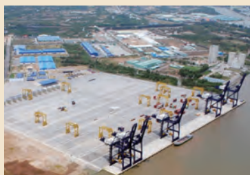
写真3 SPCT完成写真
