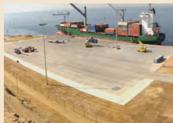
写真2 ナミベ港完成写真
