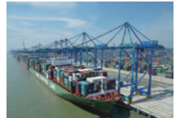
マレーシアWestportsに納入された 岸壁クレーン (P.15)
